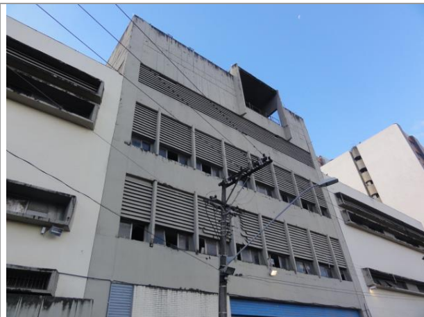
Vista Parcial Externa.
