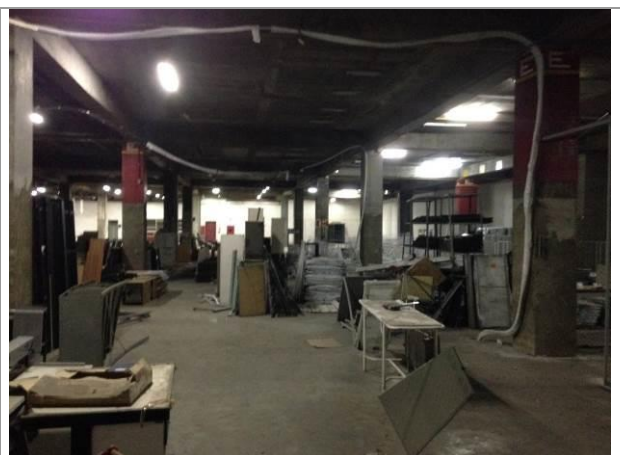
Vista Parcial Interna. - 2º Andar - Vago
