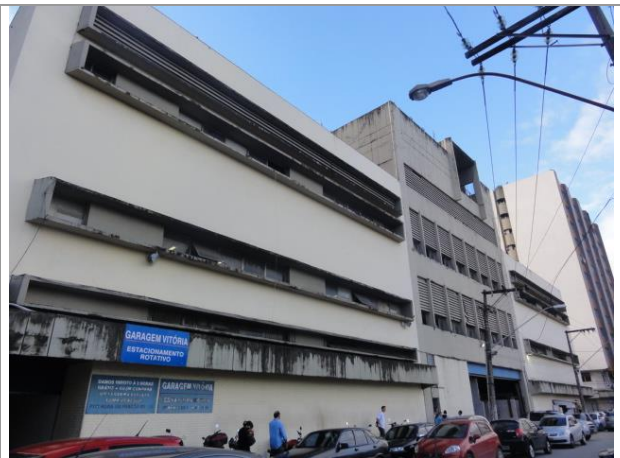
Vista Parcial Externa.
