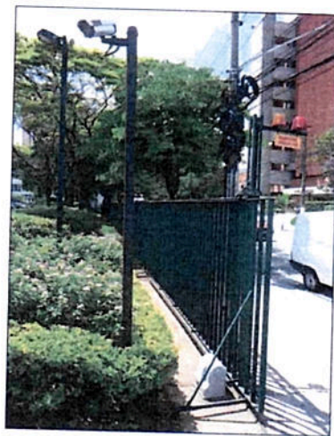
Portões de correr motorizados, atingidos pelo ato expropriatório.
