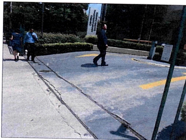
Trecho pavimentado de acesso do edifício atingido pela faixa desapropriada.
